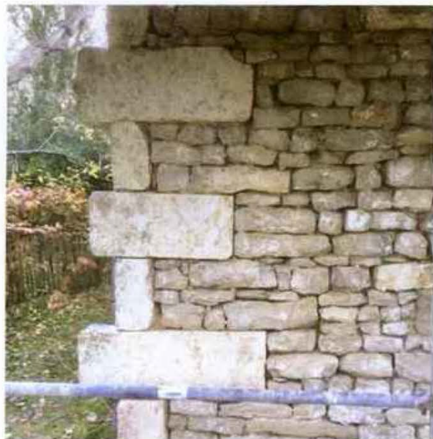
Changement de pierres d'angle en façade.
